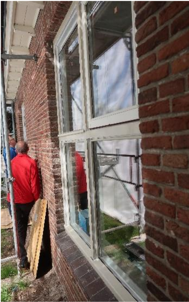
HR++ glas in de buitengevels
